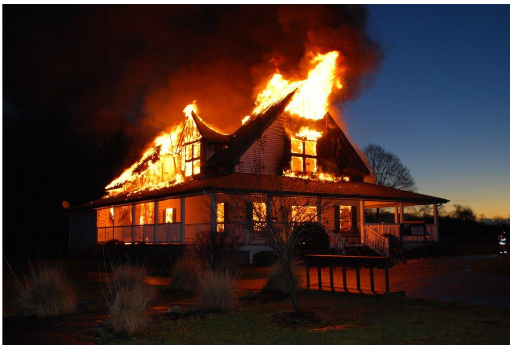
Foto 4. Yong'in bilan kuzatilayotgan gaz havo aralashmasining portlash sodir bo'lgan ob'ektning ko'rinishi.
